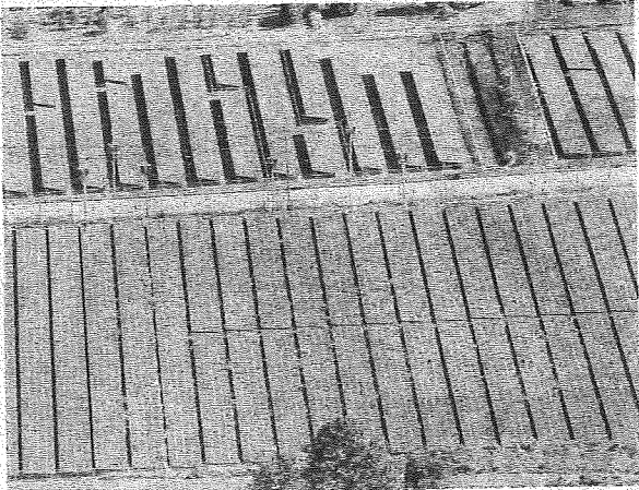
九州では太陽光発電の供給力が増えている。(熊本県内の太陽光パネル)
